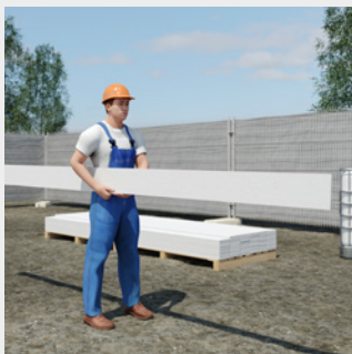
HardiePlank® Bretter bei der Montage immer hochkant tragen.
