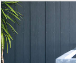
Die Befestigung ist mit Nägeln, aber auch mit kopfbeschichteten Schrauben möglich.
