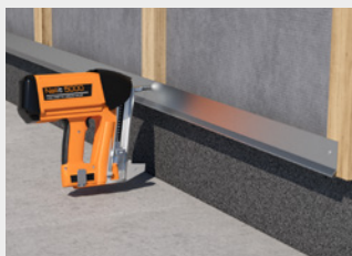
Befestigung des Sockel-Lüftungsprofil.
