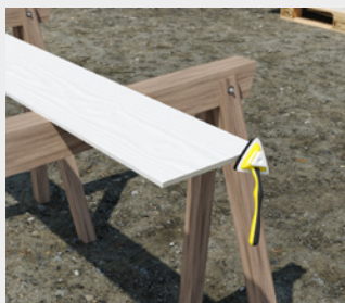
Auftragen der ColourPlus™ Kantenversiegelung vor der Montage.
